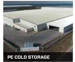
PE COLD STORAGE
